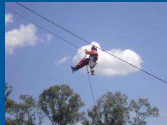
TROCA DE CABOS, LIMPEZA E LUBRIFICAÇÃO FORÇADA
